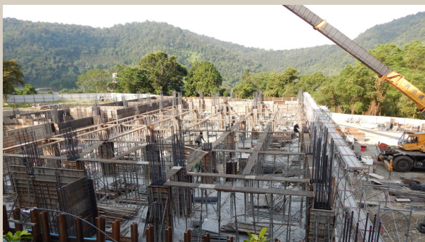
2014 年 10 月 12 日 崇德學院地下停車場柱筋與板模施工
