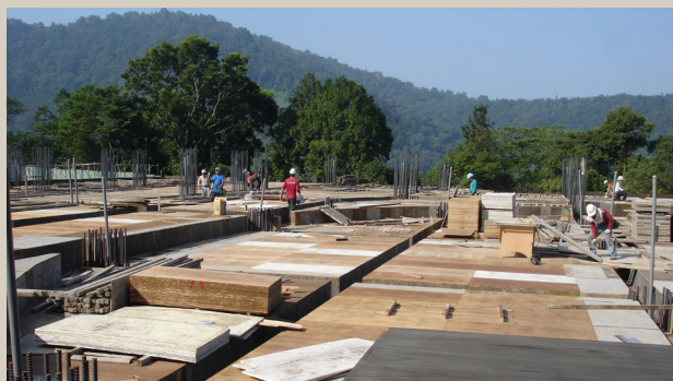
2014年10月18日 崇德學院廣場地板板模施工
