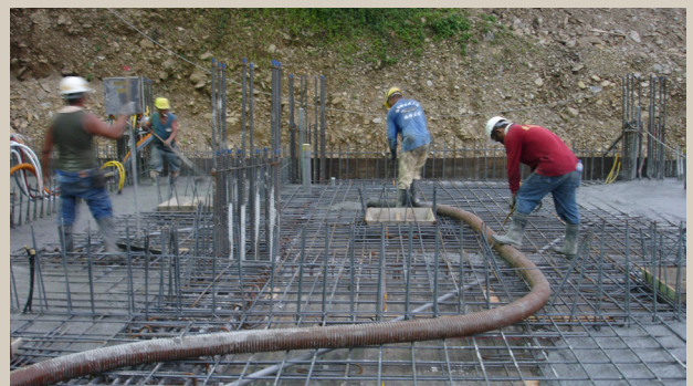
2014 年 10 月 1 日 進行停車場地板水泥澆置工程
