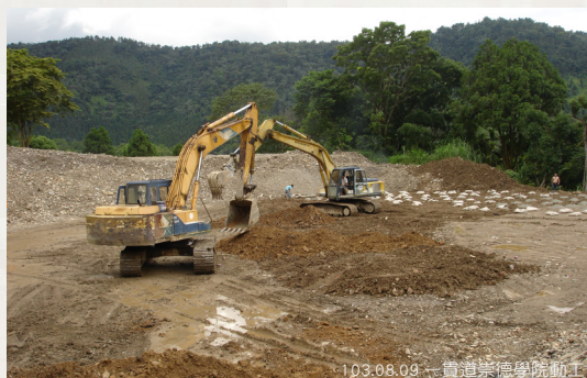
103.08.09 一貫道崇德學院動工
